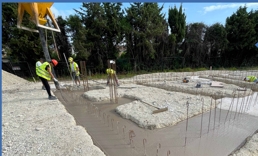
Fondations d'une école en béton ECOPact
